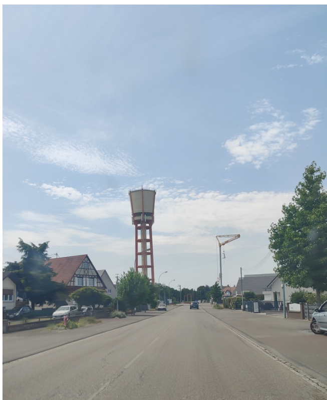
Figure 34 - Les châteaux d'eau marquent l'un des rares repères paysagers de la plaine alluviale (Photo AdT).
