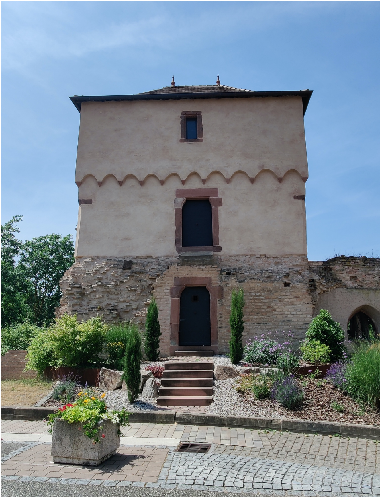
Figure 35 - Monument historique de la Tour des Bouchers à Lauterbourg (Photo AdT).
